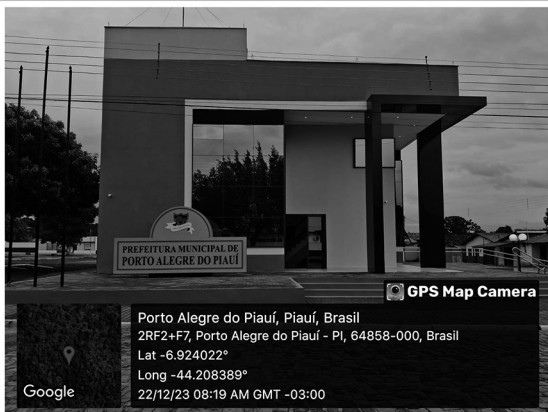
Foto 4 – Construção da Sede da Prefeitura Municipal de Porto Alegre do Piauí
